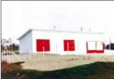
Снимка 2. Ремонтниран склад за съхранение на залежали пестициди
